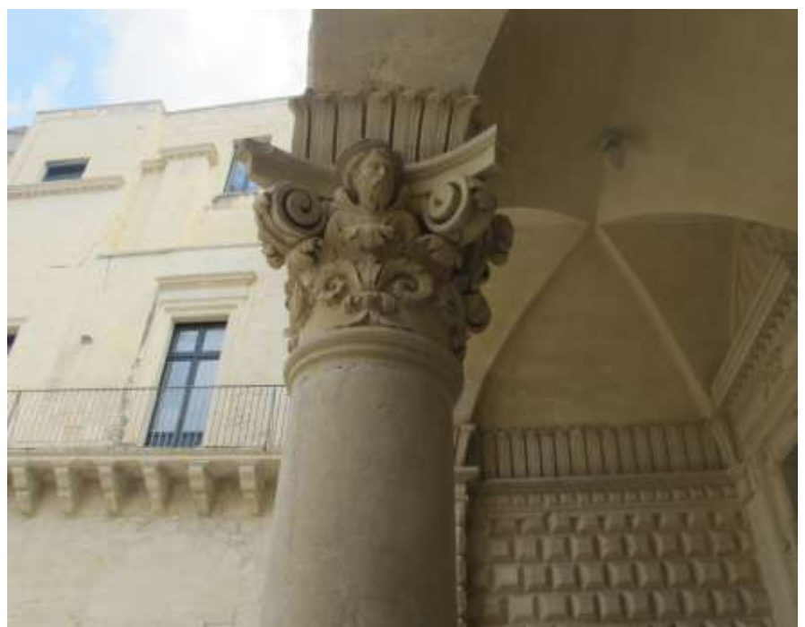
Ingresso del Palazzo (Sede della Presidenza della Provincia di Lecce), ambienti interni e sotterranei.
